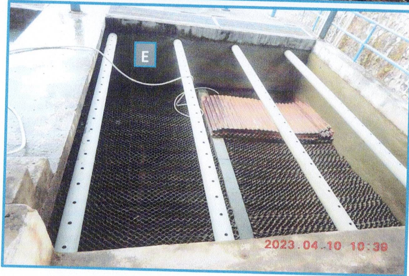
E. Tube Settler WTP 40 Eksisting yang akan direhabilitasi
