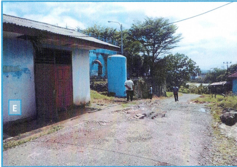
E. Lokasi Rencana Rehabilitasi Rumah Pompa Booster Eksisting menjadi Rumah Operator Shift dan Laboratorium Air.
